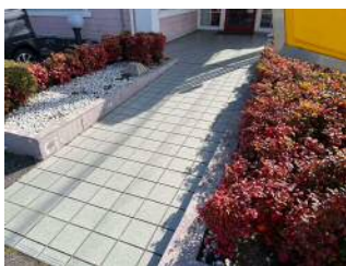
スロープの設置
